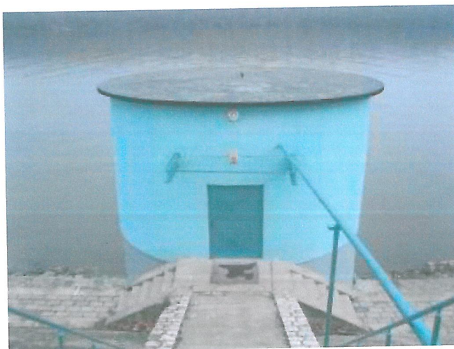
Slika 2.1. Zahvatna građevina na Dunavu.
